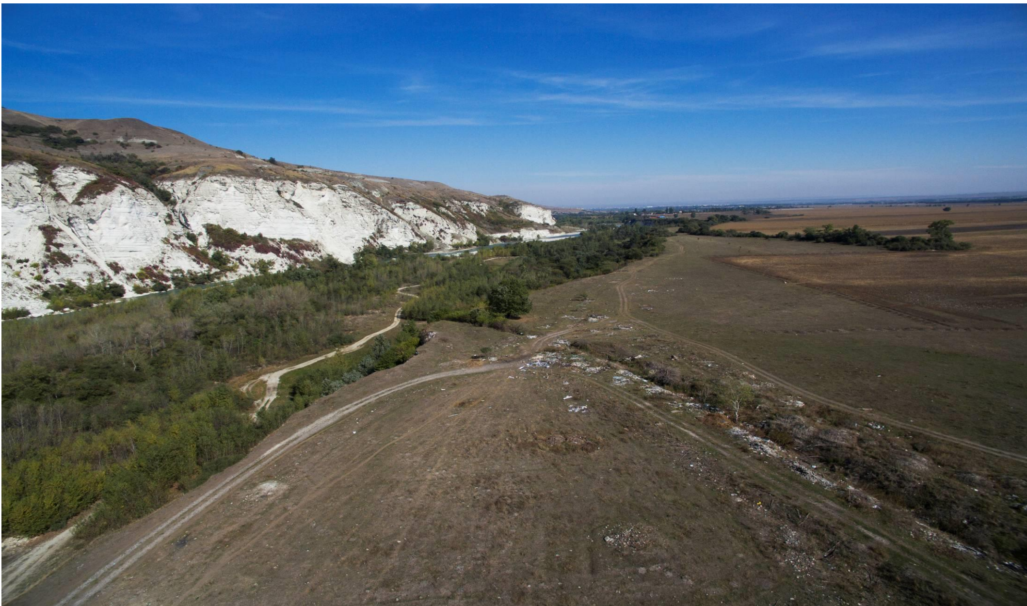
Фото с воздуха №48. Несанкционированная свалка в северной части г. Усть-Дзегута на правом берегу р. Кубань. Географические координаты (северная широта: 44,11832; восточная долгота: 41,97752).
