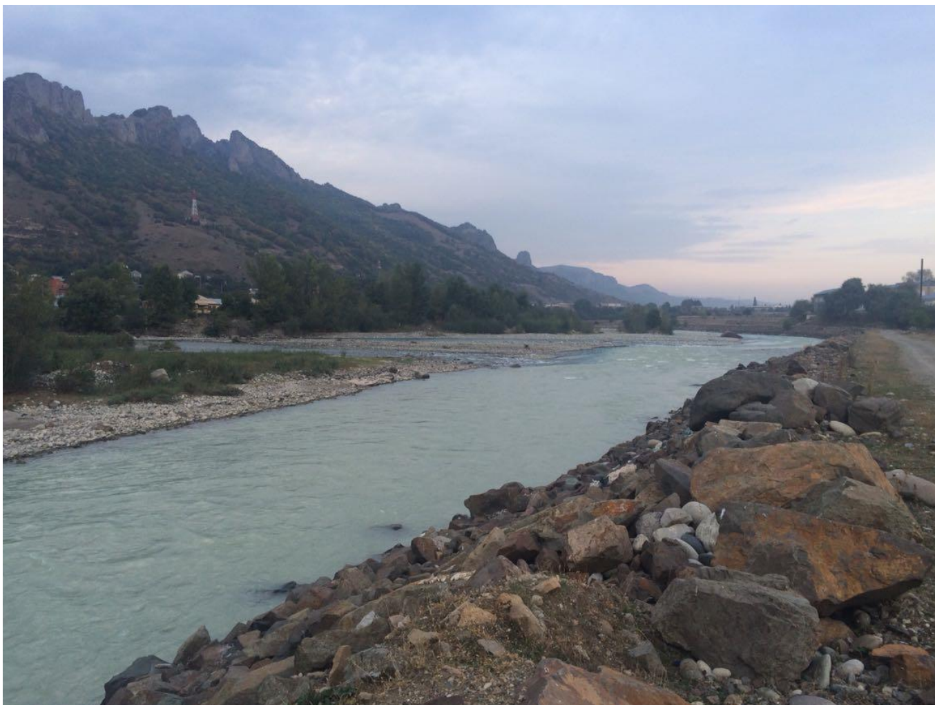
Фото 22. Укрепление правого берега р. Кубань каменной наброской на протяжении 2,0км.
