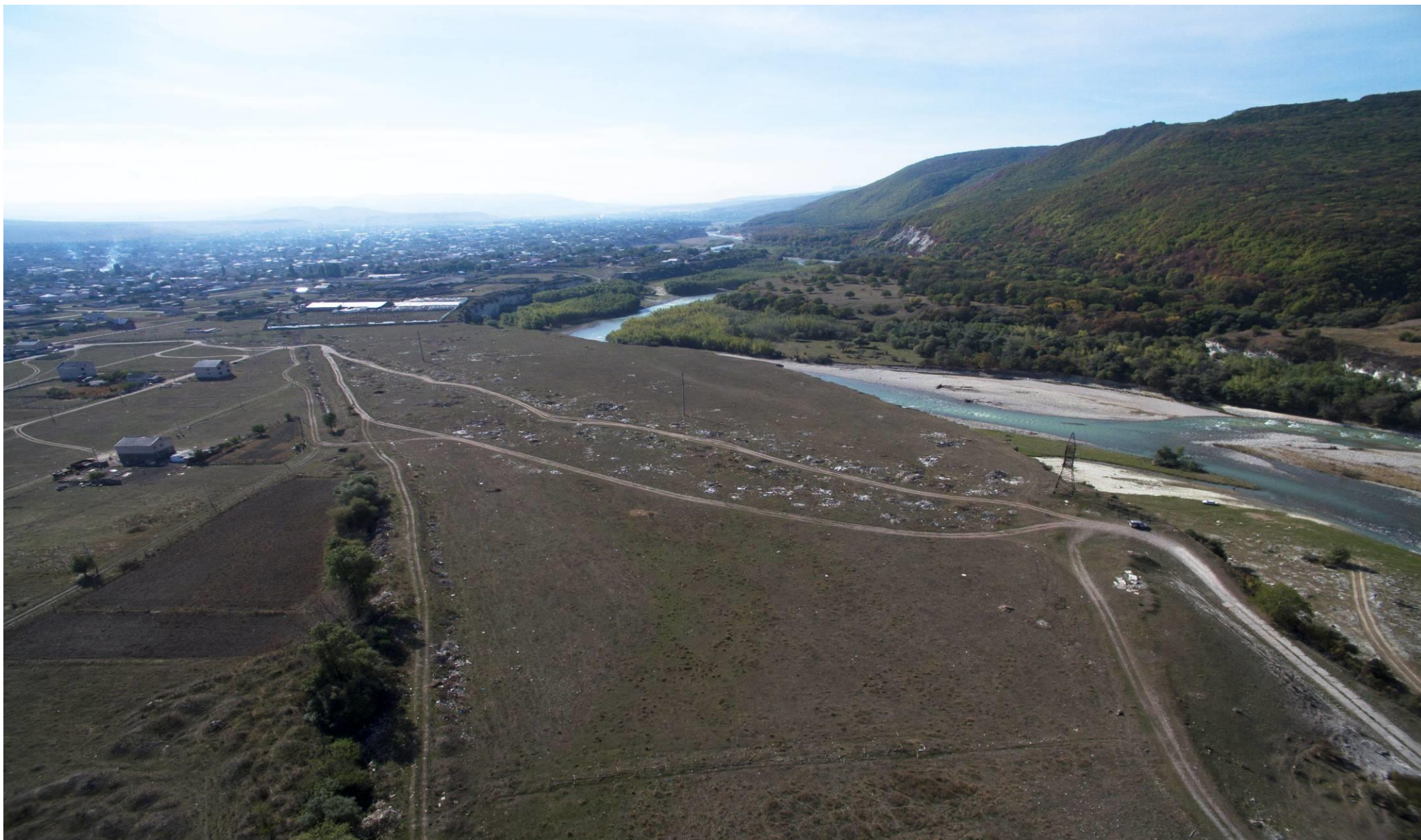
Фото с воздуха №50. Несанкционированная свалка в северной части г. Усть-Дзегута на правом берегу р. Кубань. Географические координаты (северная широта: 44,11832; восточная долгота: 41,97752).
