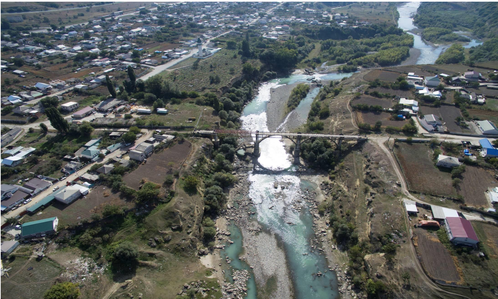
Фото с воздуха №29. Свалки мусора вдоль левого и правого берега р. Кубань в г. Усть-Джегута и а. Кубина. Географические координаты (северная широта: 44,06778; восточная долгота: 41,96068).
