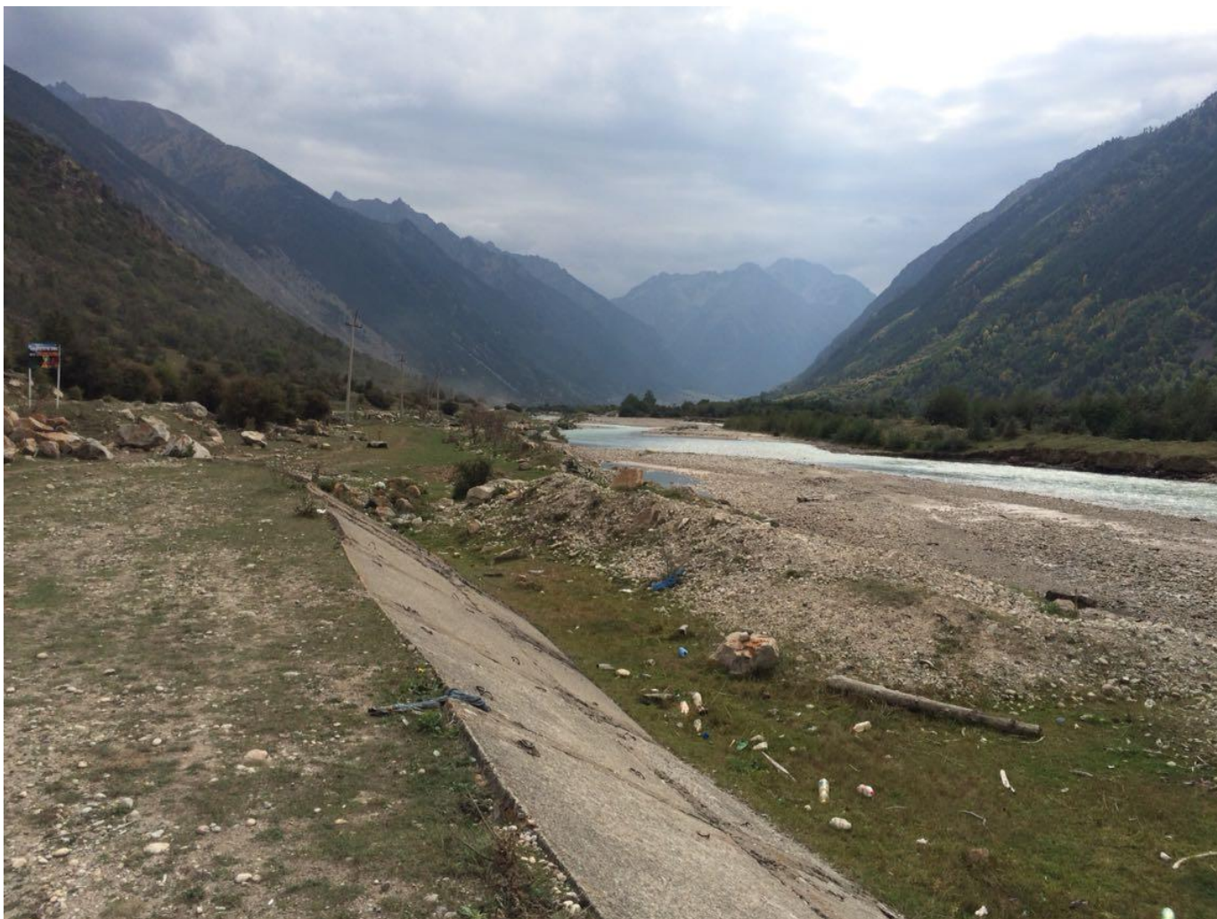
Фото 6. Укрепление правого берега р. Кубань на протяжении 1.5км в а. Хурзук.
