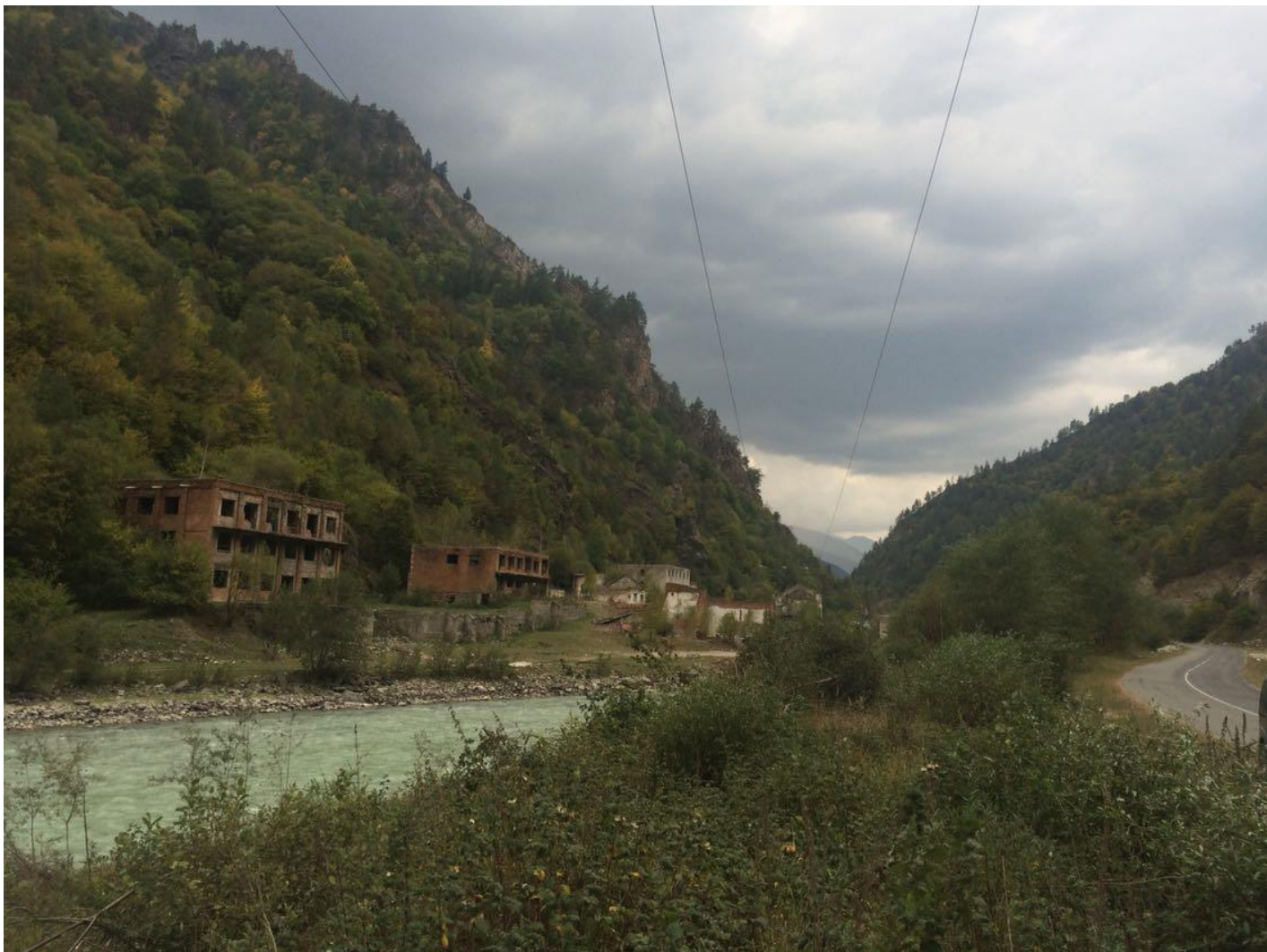
Фото 12. Разрушенные сооружения Эльбурского рудника.
