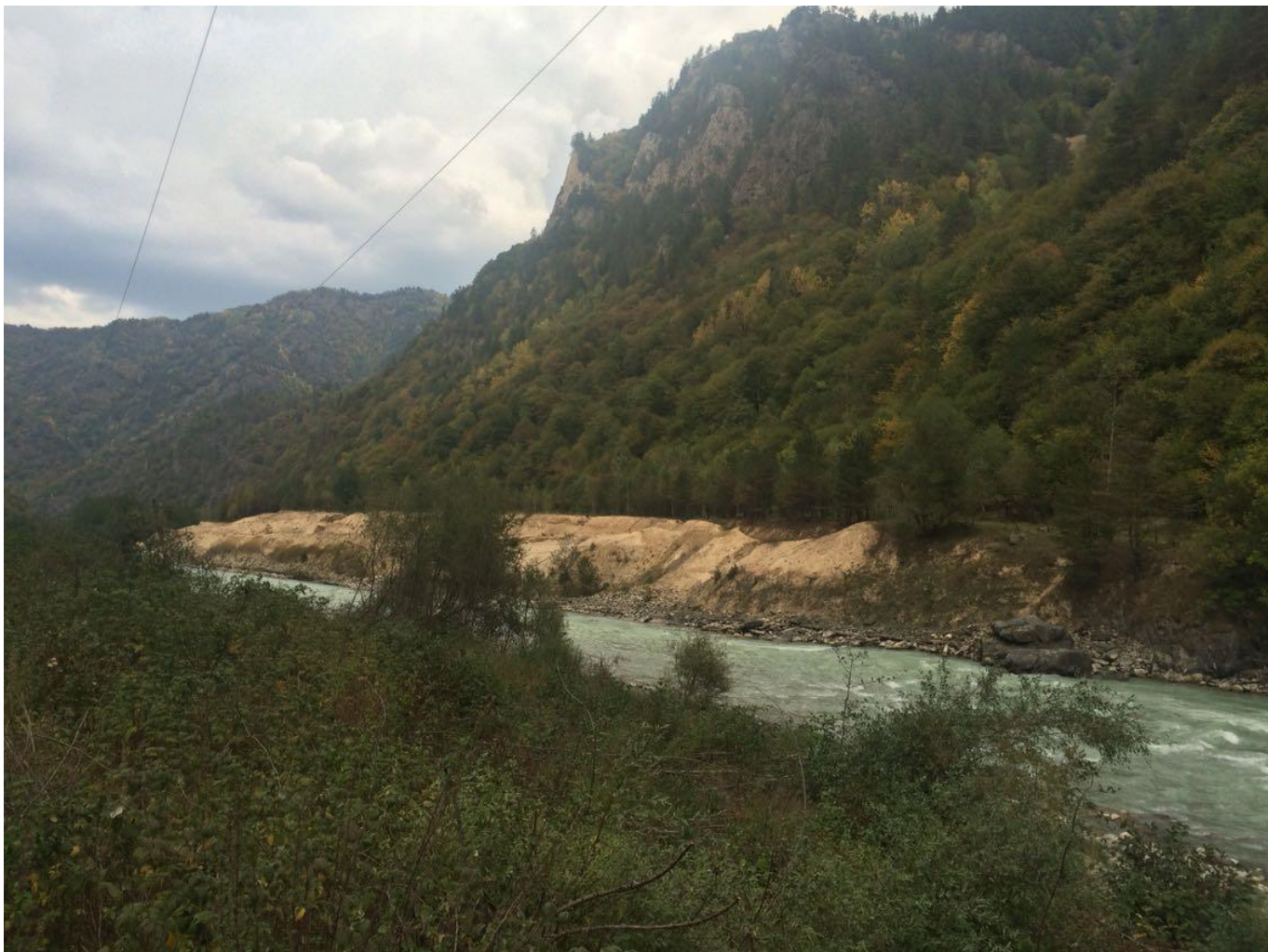
Фото 13. Хвостохранилище Эльбрусского рудника на правом берегу р. Кубань.
