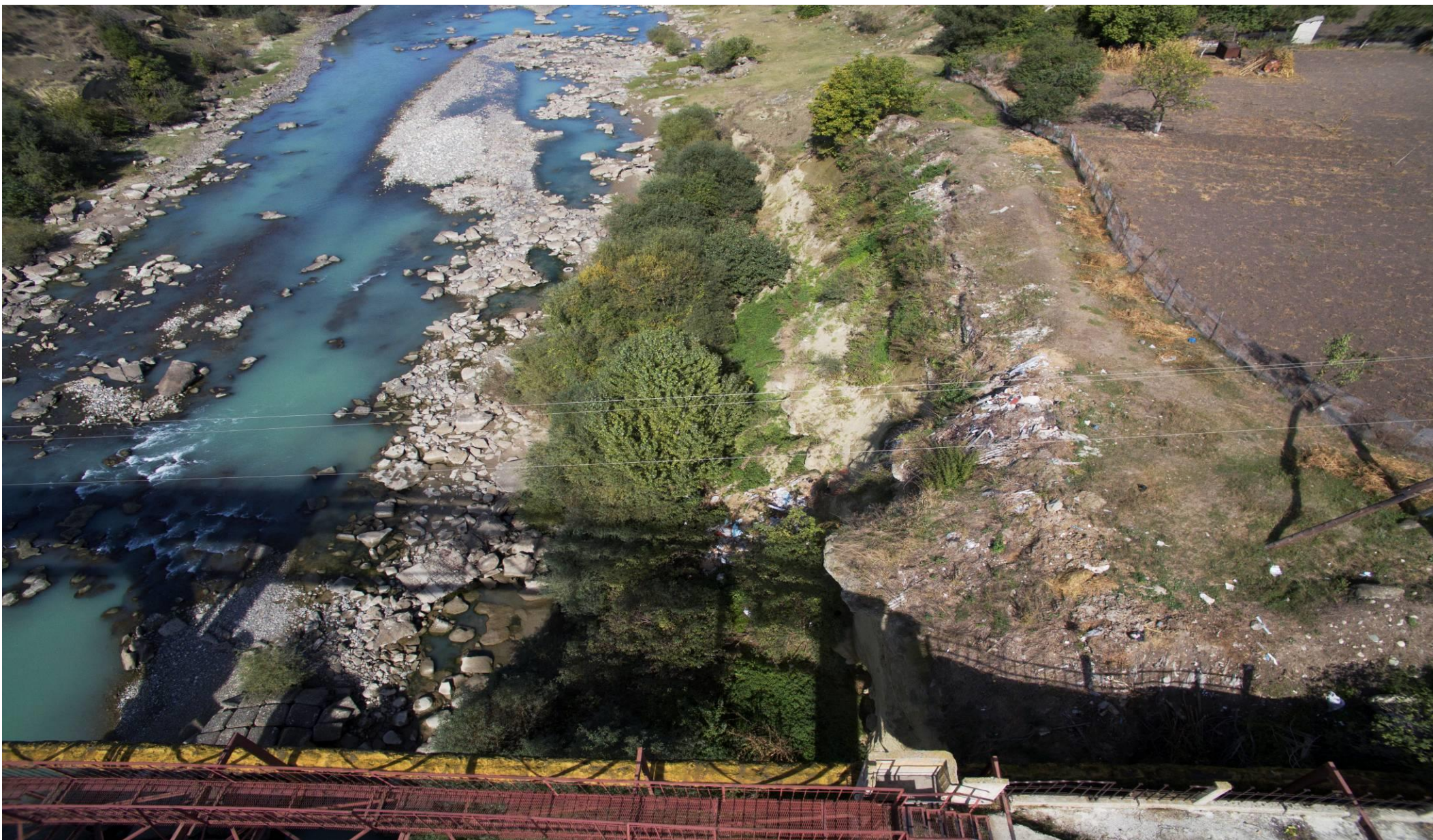
Фото с воздуха №22. Свалки мусора вдоль левого и правого берега р. Кубань в г. Усть-Джегута и а. Кубина. Географические координаты (северная широта: 44,06778; восточная долгота: 41,96068).
