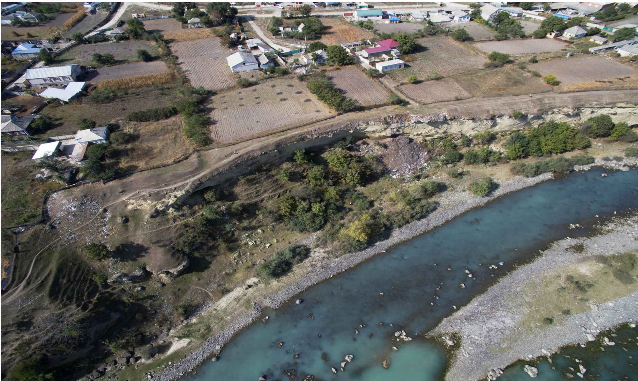
Фото с воздуха №32. Свалки мусора вдоль левого и правого берега р. Кубань в г. Усть-Джегута и а. Кубина. Географические координаты (северная широта: 44,06778; восточная долгота: 41,96068).
