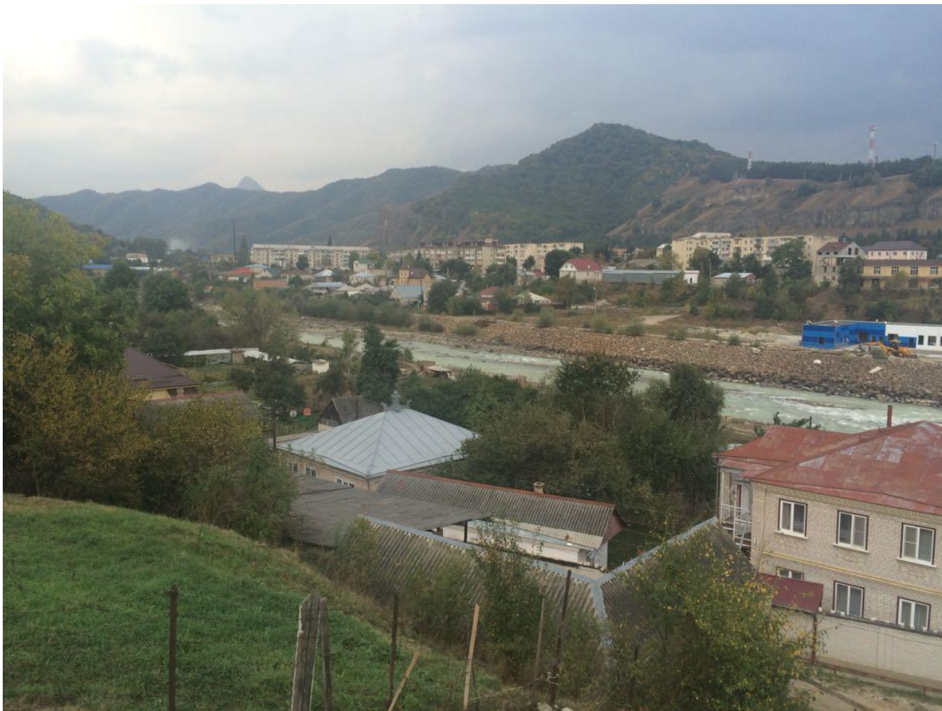
Фото 21. Укрепление левого берега р. Кубань каменной наброской на протяжении 2,2км в г. Карачаевске.
